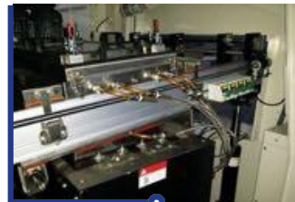
Sistema de Nitrógeno (N2)
